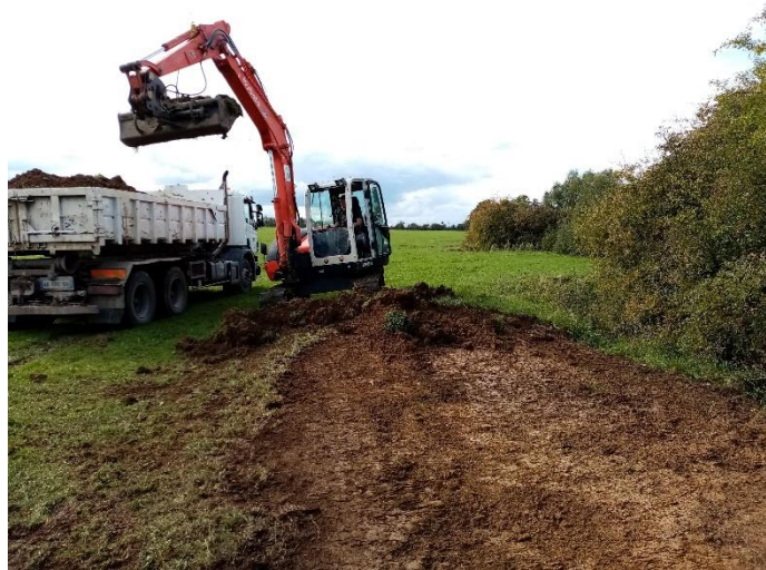
Photo : Arasement du merlon en cours de chantier
