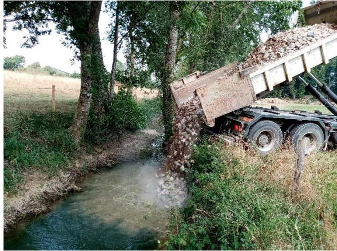
Photo : déversement des granulats directement dans le lit de la rivière à l'aide d'un camion 6x4.
